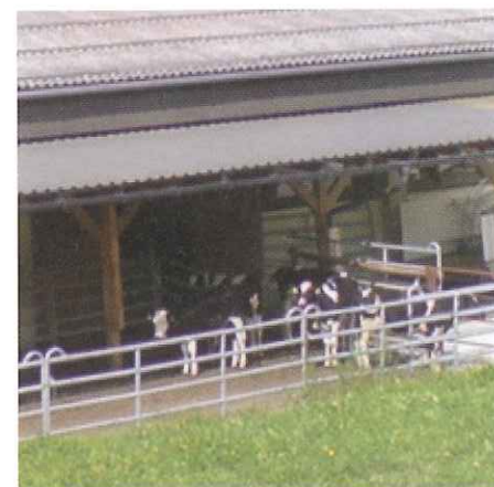
Abbildung 1: Ungedämmtes Vordach mit Auslaufmöglichkeit.
