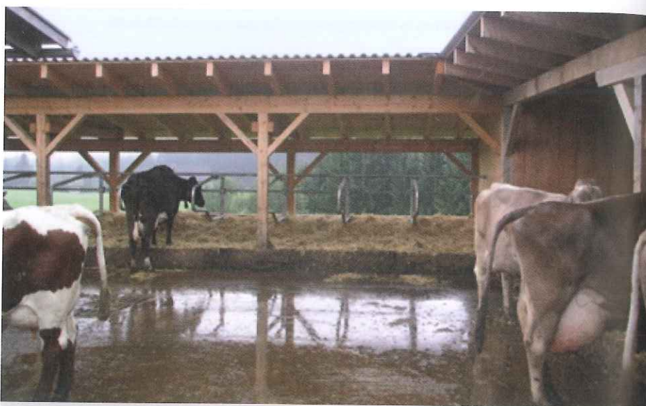
Abbildung 5: Auslauf und überdachte Liegeboxen in Kaltdachausführung.
