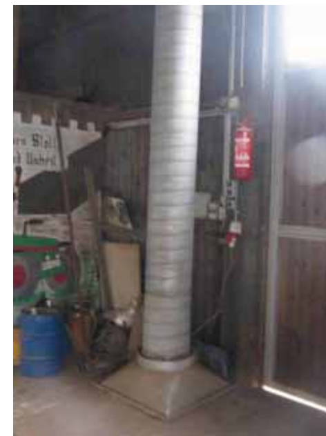
Unterflurabsaugung mit altem Heugebläse
