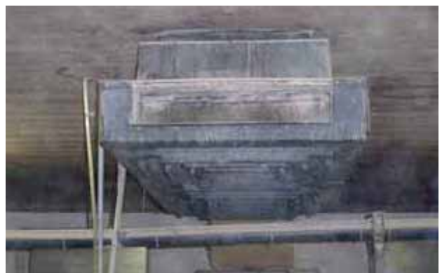
Abbildung 4: Rechteckige Strahl Lüftungseinheit mit Öffnungen in 4 Richtungen
