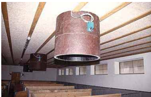
Abbildung 16: Klassische Porendecke mit Heraklith - Holzwolleplatte
