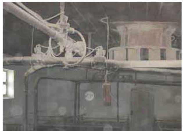
Abbildung 3: Zentrale Strahl Lüftungseinheit mit 360° Öffnungen
