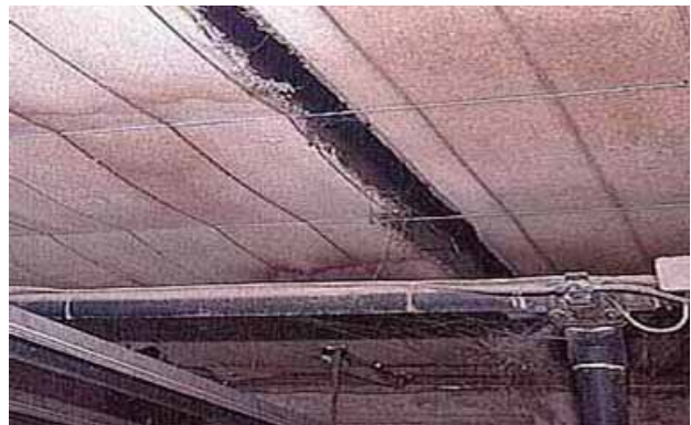
Abbildung 8: Textilgeflechte haben keine lange Lebensdauer
