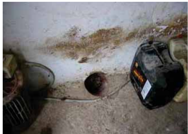
Abbildung 19: Direkter Falschlufteintrag in das Abteil
