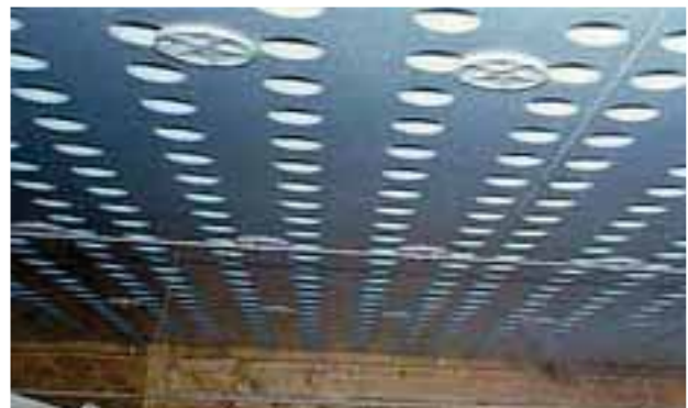
Abbildung 9: Gelochte Kunststoffplatten als Zuluftelement
