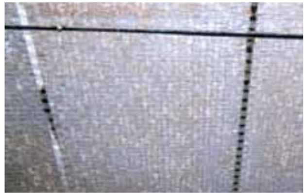
Abbildung 7: Textil- oder Kunststoffgeflecht (ACC) als Zuluftelement
