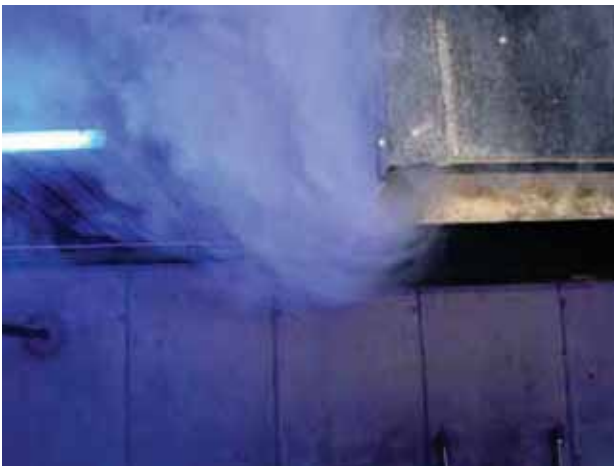
Abbildung 23 und 24: Frsichluft wird unmittelbar wieder abgesaugt. Die Wärmebildaufnahme verdeutlicht diesen Mangel.
