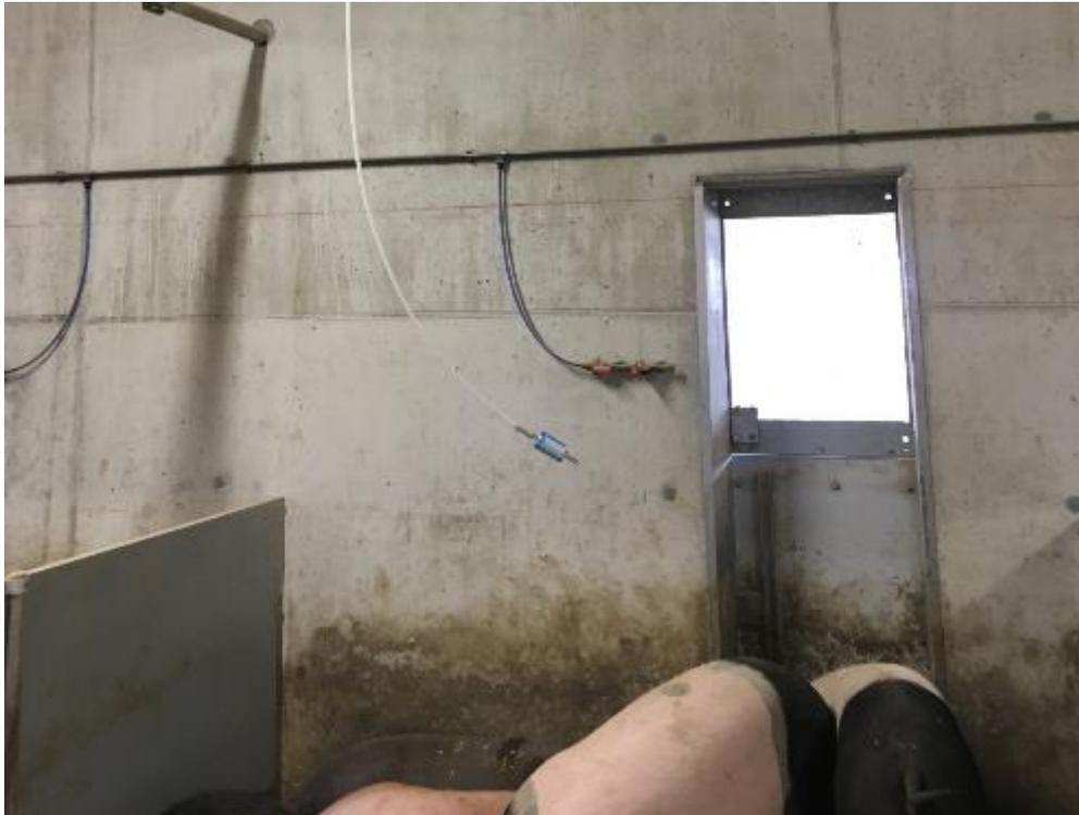
Abbildung 8: Gasmessleitung mit Staubfilter im Ruhebereich der nördlichen Bucht
