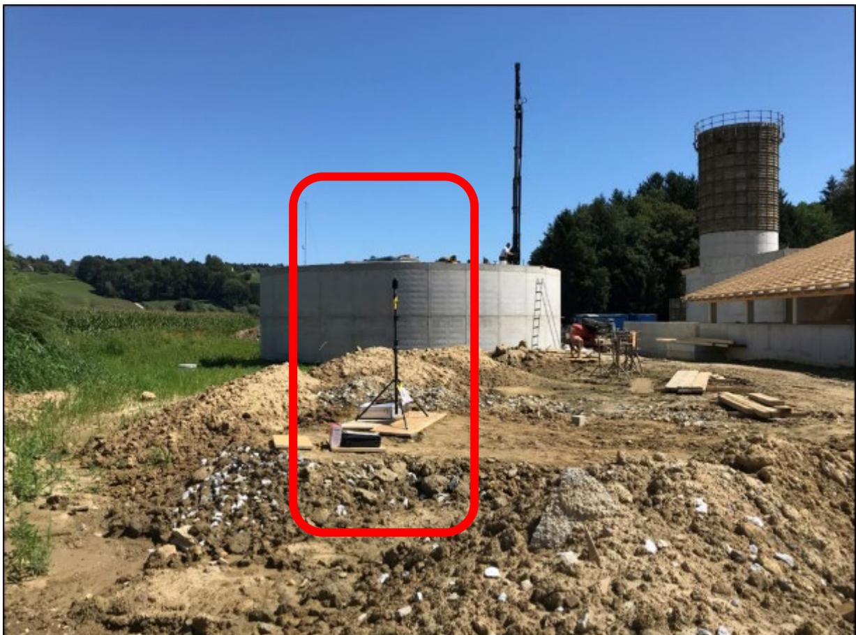
Abbildung 14: Mikrofonposition zur Erhebung der Schall-Ist-Situation (rot umrandet), Blickrichtung Osten
