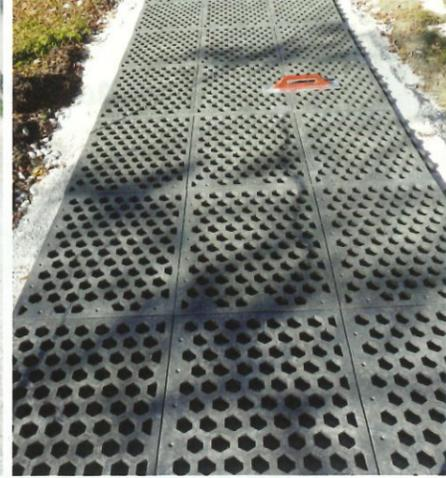
Werden für den Triebweg Hackschnitzel verwendet, sollte beachtet werden, dass diese regelmäßig erneuert werden müssen und bei Starkregen eventuell auch mitgerissen werden. Eine teurere Alternative bietet das Verlegen von Lochmatten.
