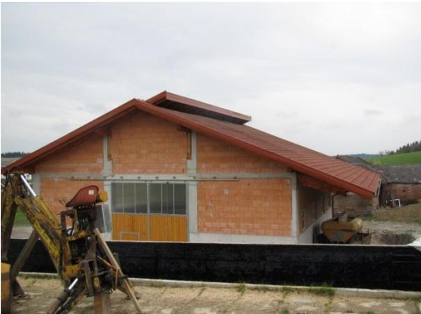
Abbildung 14: Maststall Außenansicht mit einseitig verlängertem Luftfirst.
