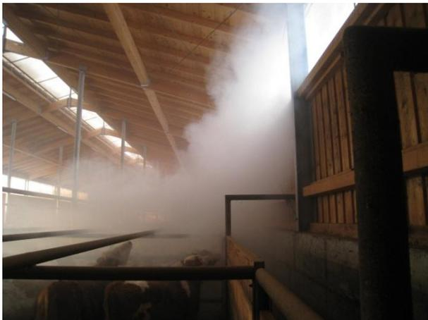
Abbildung 5: Künstlicher Nebel verdeutlicht die Luftführung in den Tierbereich
