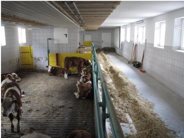
Abbildung 10: Mastkälber (Fresser) im umgebauten Stall mit Strahlungswärme unter der Porendecke
