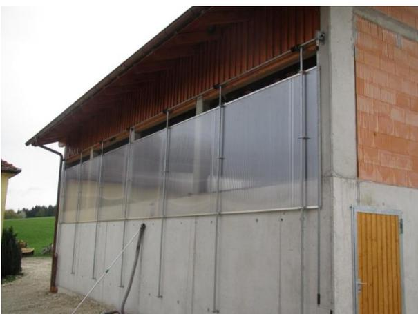
Abbildung 15: Maststall Außenansicht mit regelbaren Doppelsteg - Zuluftelementen
