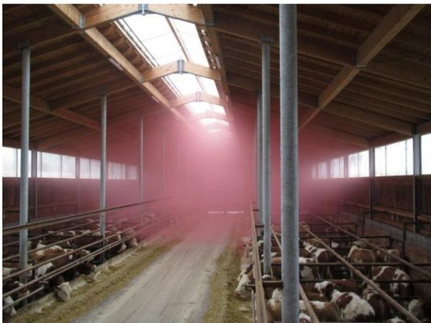
Abbildung 30: Kontrolle der Luftverteilung mit roter Nebelpatrone.
