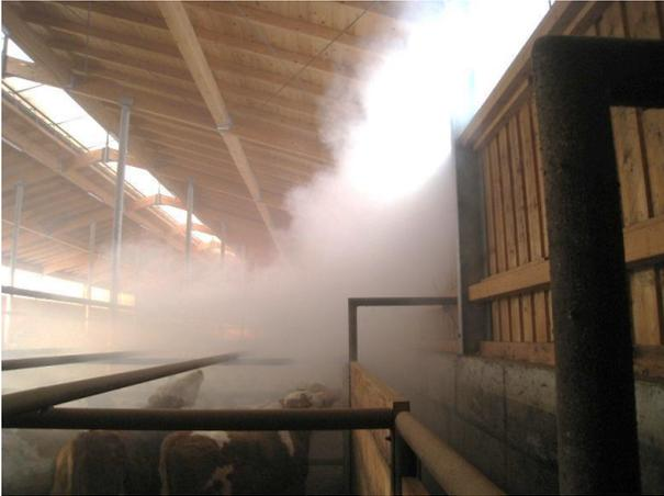
Abbildung 17: Ungünstige Zuluffführung in das Stallinnere im Dezember
