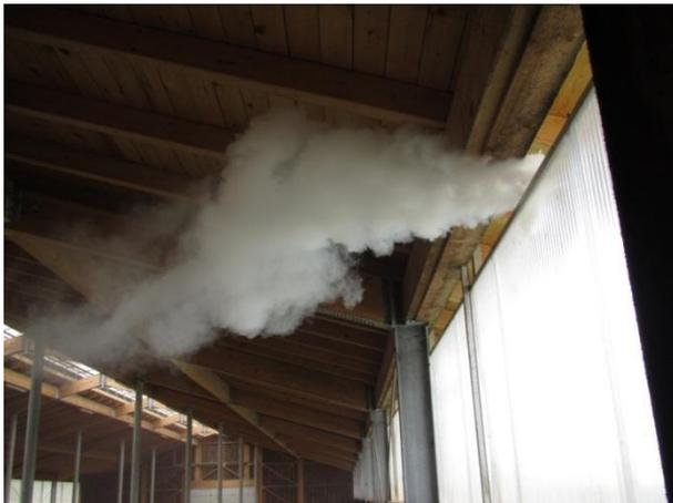
Abbildung 16: Optimale Zuluftführung in das Stallinnere im April
