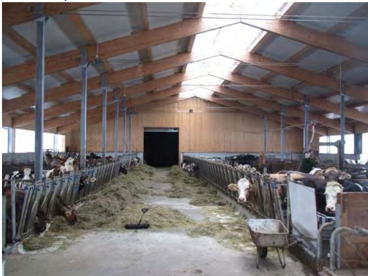
**Kälber auf Tieflauf, Zuluft über mech. regelbare Doppelstegplatten, Abluft Luft- Lichtfirst**
