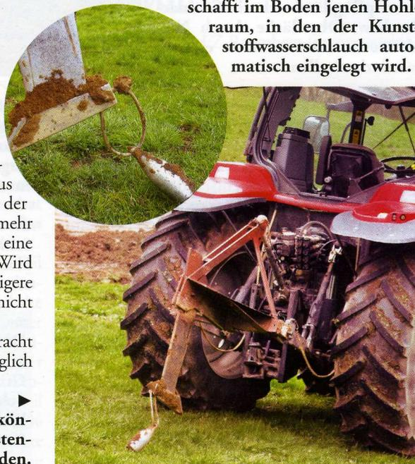
sehen. Sehr rasch und billig – weil ohne Aufgraben – kann eine Wasserleitung mit Hilfe eines Maulwurfspfluges verlegt werden. Dieser Pflug mit einem Schar und einem angehängten Maulwurfskörper wird üblicherweise auf staunassen Flächen eingesetzt, um Röhren zum Vorfluter zu ziehen, in denen das Wasser abgeleitet werden kann. Es lassen sich mit diesem Gerät allerdings auch sehr leicht Wasserleitungen verlegen. Aufge-
