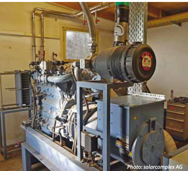
BHKW der Biogasanlage
