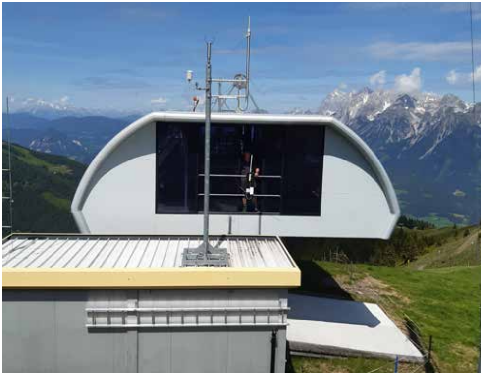
Abbildung 2: LORA Antenne Hauser Kaibling, Bergstation Gipfellift
