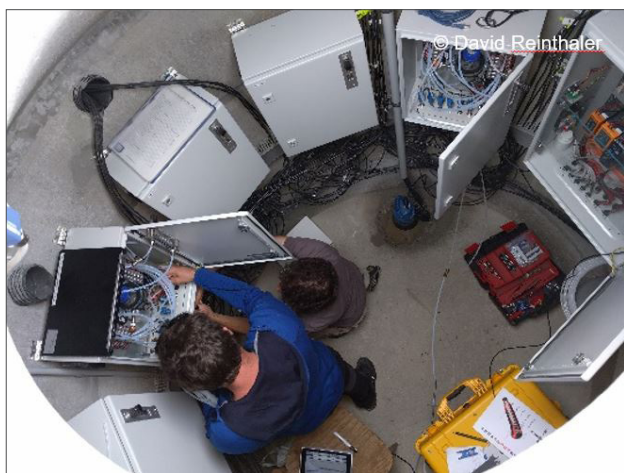
Abbildung 2: Schacht für Tiefenprofilmessungen.
