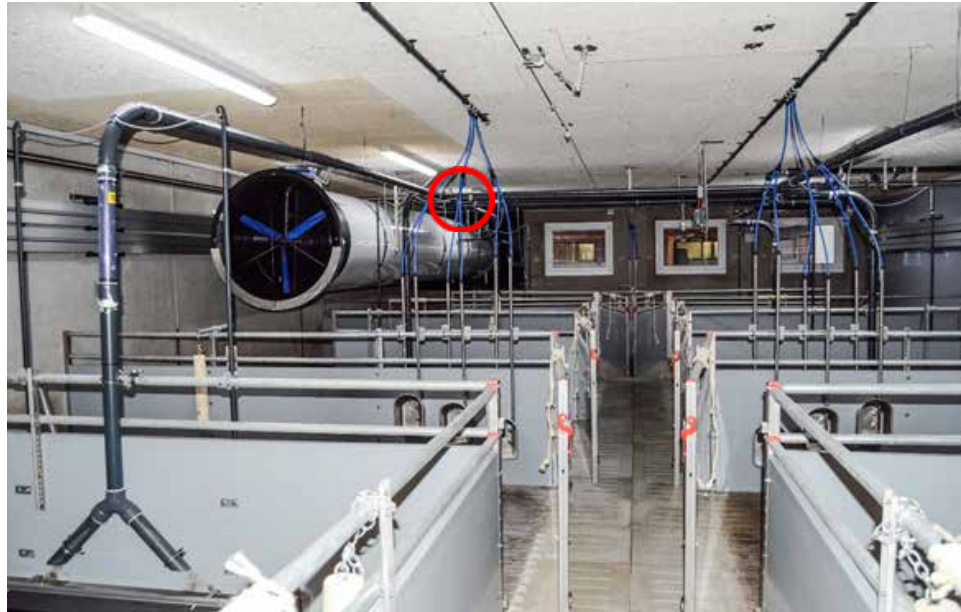
Abbildung 4: Blick in ein Mastabteil; rot gekennzeichnet ist die Schadgas-Messstelle im Rohgas
