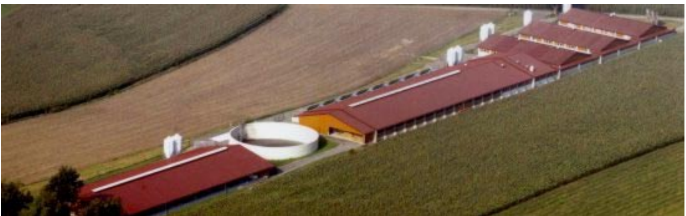
Foto 2: M-Styria Zuchtsauenstall, fertiggestellt 07/2002
