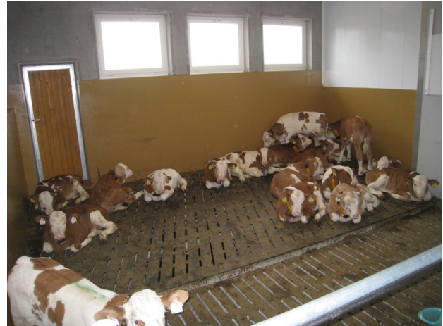
Abbildung 5: Liegefläche in Betonspalten mit Gummiauflage
