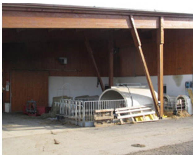
Abbildung 1: Iglus und Gruppeniglu im überdachten Bereich
