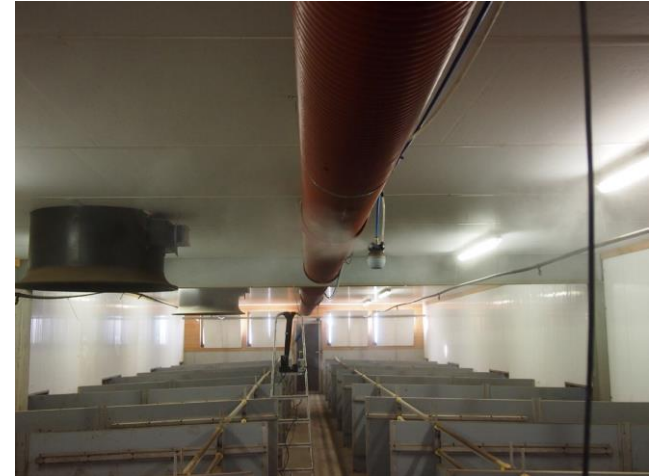
Kühlung der Stallluft durch Zweistoffdüsenteknik (Foto: I. Mösenbacher-Molterer)
