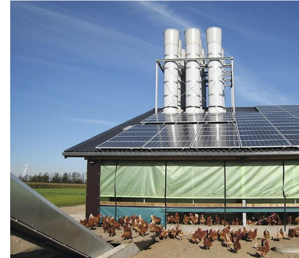
Oberflurkamine als technischer Bestandteil der Tunnellüftung (Foto: bigdutchman.de )
