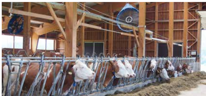
In Milchviehherden kommt einer ausreichenden Kühlung besondere Bedeutung zu. Die Steuerung von Ventilatoren durch einfache, temperaturabhängige Regelschalter stellt bereits eine sehr wirksame Automatisierung dar Foto: I. Mösenbacher-Molterer
