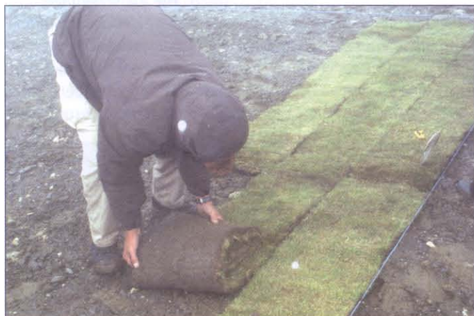
Verlegung von Alpinem Fertiggras
