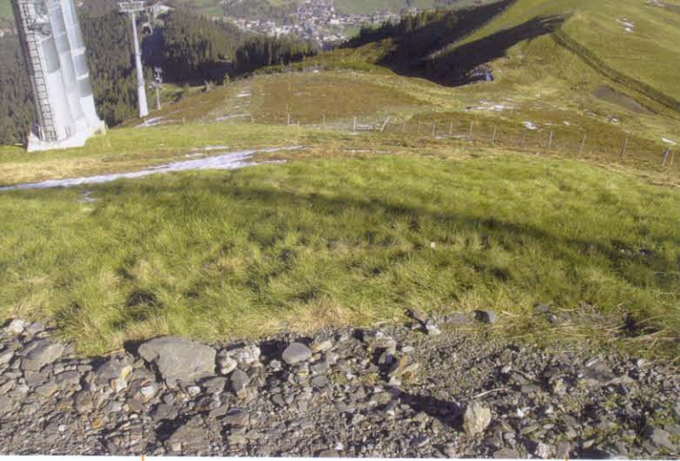
Im Vordergrund: Schwierig zu begründendes Material. Im Hintergrund: Erfolgreiche Begrünung mittels alpinen Fertigrasen (Saalbach, Bergstation SchattbergXPress)
