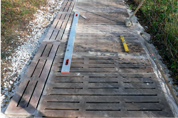
Alte Betonspalten sind begrünbar und preisgünstig. Fraglich ist, ob man welche bekommt und wie hoch die Rutschgefahr ist.
