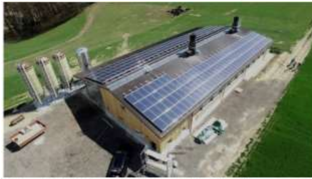
© Solarwatt Schweiz / Die neue Geflügelfarm mit dem Solardach
