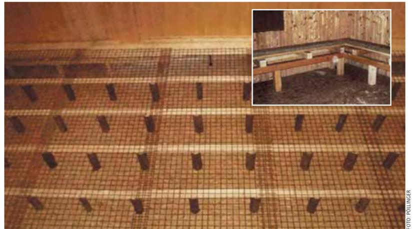
Eine Trocknungsbox mit Baustahlgitter auf 50 cm Rundhölzern.
