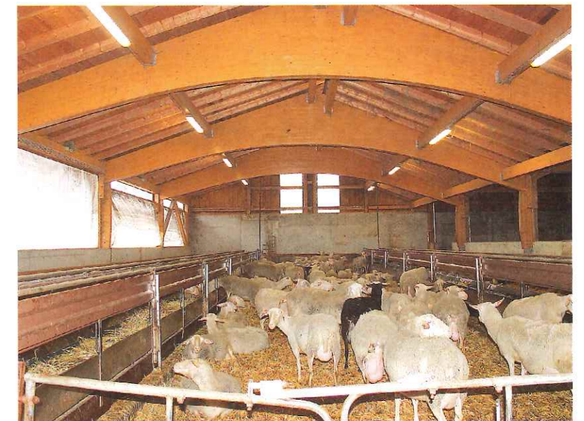
Mehrere Lampen im Stall verteilt sorgen für eine gleichmäßige Ausleuchtung.
