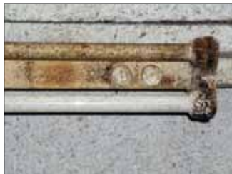
verschmutzte Leuchtstoffröhre
