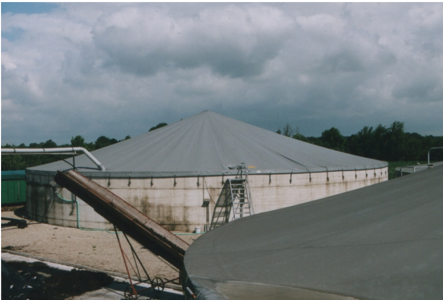
Abbildung 5: Zeltdächer sind vor allem für sehr große Güllegruben eine Möglichkeit den vorhandenen Güllelagerraum ohne Niederschlagswasser gut zu nutzen. Der bauliche Aufwand ist nicht unerheblich.
