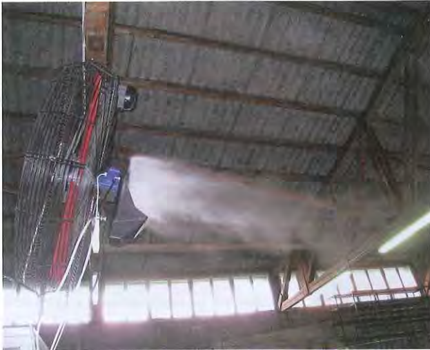
Deutlich ist zu sehen, wie das Wasser vom Ventilator versprüht wird. Dies dient den Kühen zusätzlich als Kühlung. Fotos: Zentner
