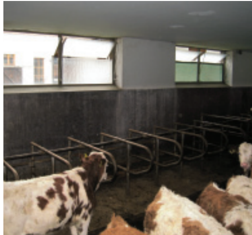
Zuluftführende Fenster über den Liegeboxen sind im Winter zu schließen.
