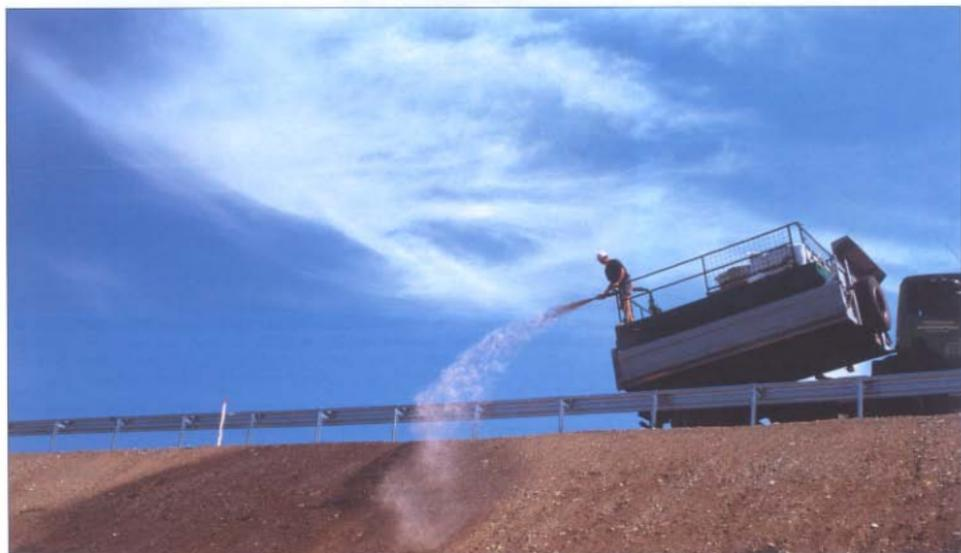
Bild 1: Die Nass- oder Hydratosaat eignet sich perfekt zur Verteilung des Saatgutes auf steilen Böschungen
