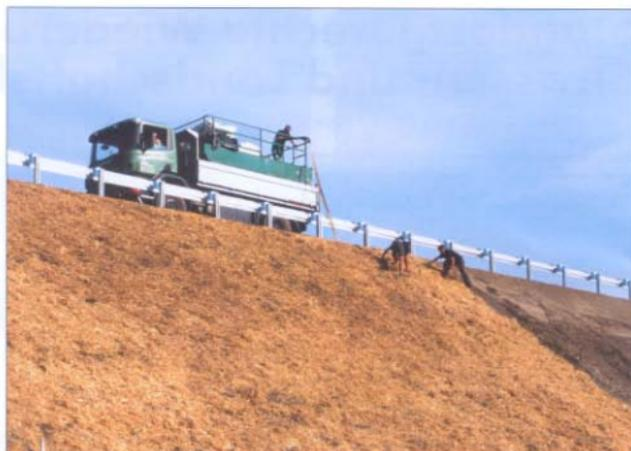
Bild 2: Bei Verwendung standortgerechter Saatgutmischungen gewährleistet eine Bitumenstrohdecksaat über zwei Vegetationsperioden ausreichenden Erosionsschutz
