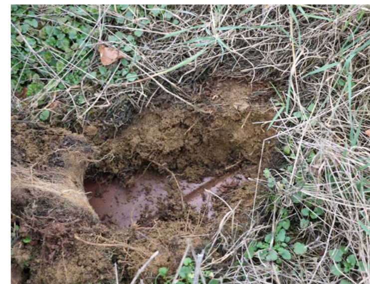
△ Der Dachaufbau ist in zwischen zirka 10cm tief. Ursprünglich rechnete der Landwirt mit rund 90kg Substrat pro Quadratmeter. Tendenziell führte er aber mehr Material aufs Dach.
