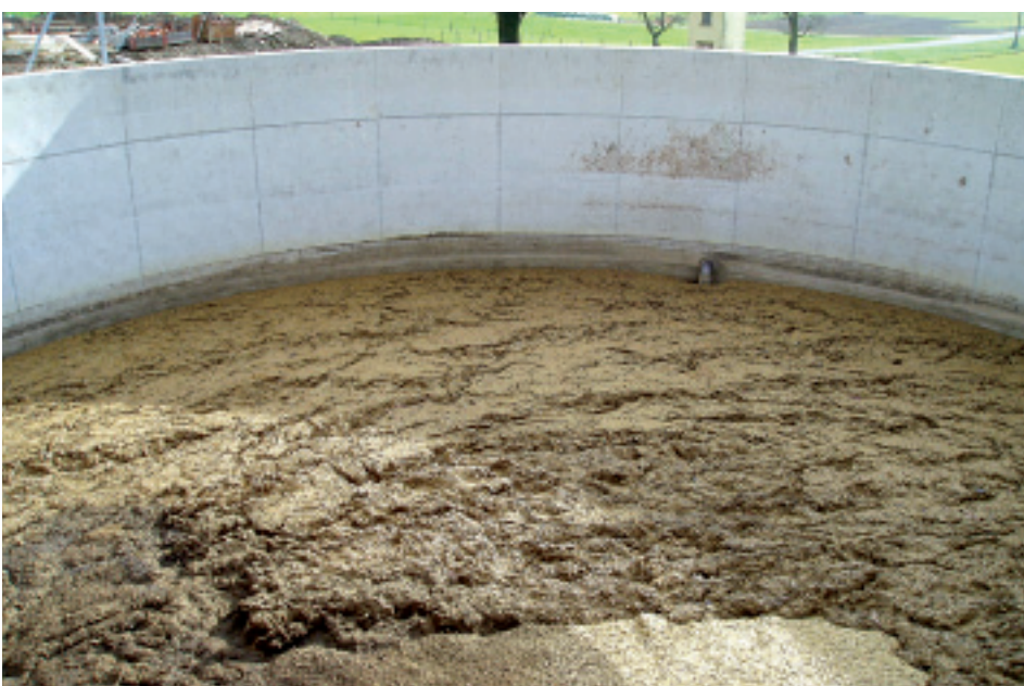
Auch natürliche Schwimmschichten verringern bei offenen Güllelagern die Ammoniakabgasung bei der Lagerung. Foto: H. Egger
