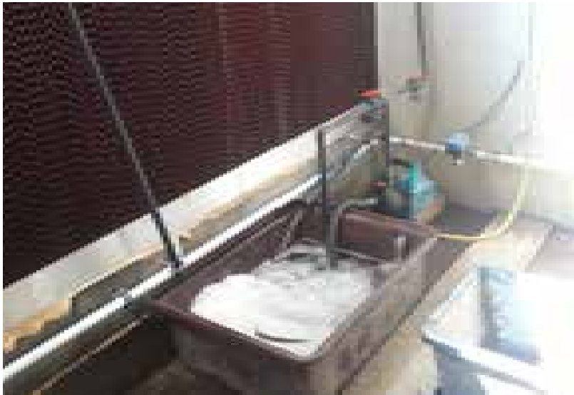
Bei Coolpads werden Zellulosewaben mit Wasser berieselt Foto: I. Mösenbacher-Molterer
