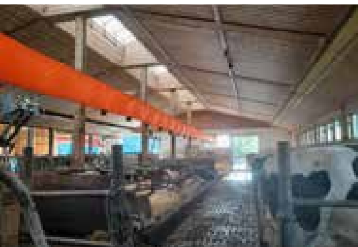
Schlauchsysteme bringen Frischluft in den Liegebereich Foto: I. Mösenbacher-Molterer
