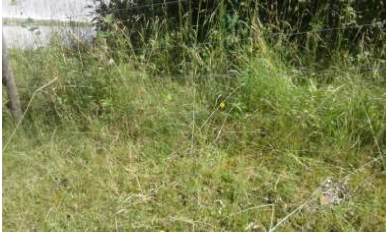
Eingewachsene Drähte/Litzen leiten den Strom ab
