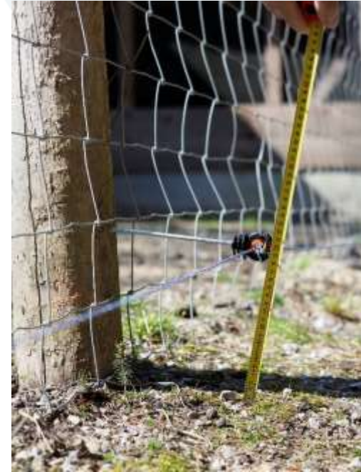
Maschengitter mit Stoppdraht
