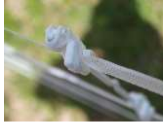
Falsche Montage Litzen brennen durch
