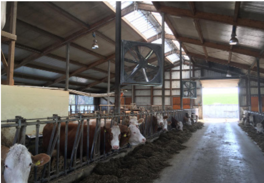
Querbelüftung vom Futtertisch aus.
