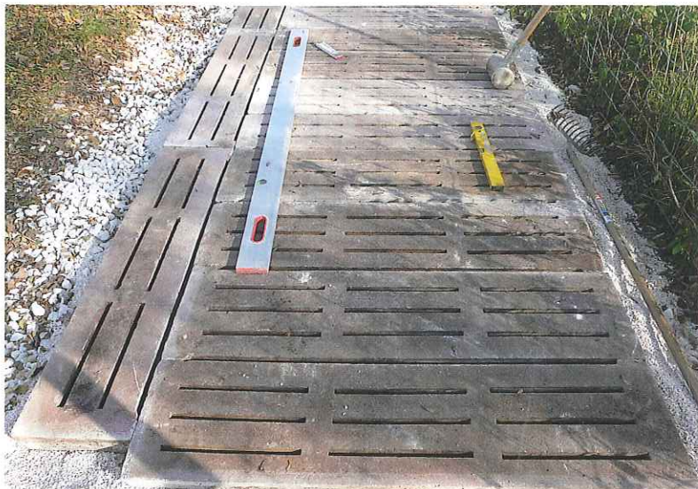
Alte Betonspalten sind begrünbar und preisgünstig. Frage ist, ob man welche bekommt. Weiteres Problem ist die mögliche Rutschgefahr.
