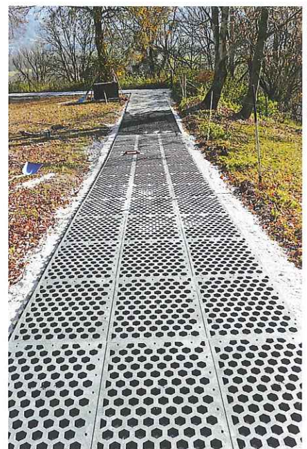
Kunststoffgittervariante „Belmondo“ vor dem Auffüllen mit Sand.
