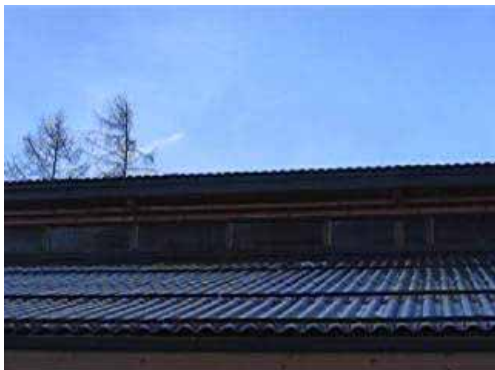
Stalltür offen – enorme Abluftverbesserung!!
