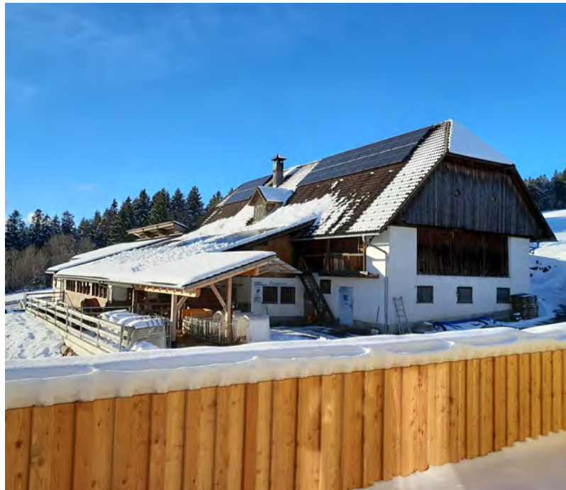
19,8 kWp PV-Anlage am Stalldach, 2 Neigungen
