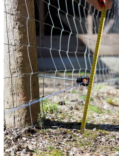
Maschengitter mit Stoppdraht
