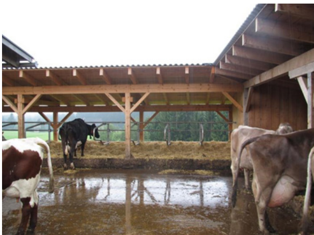
Abbildung 12: Auslauf und überdachte Liegeboxen in Kaldachausführung
