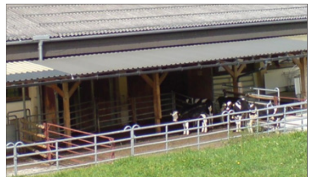
Abbildung 8: Ungedämmtes Vordach mit Auslaufmöglichkeit
