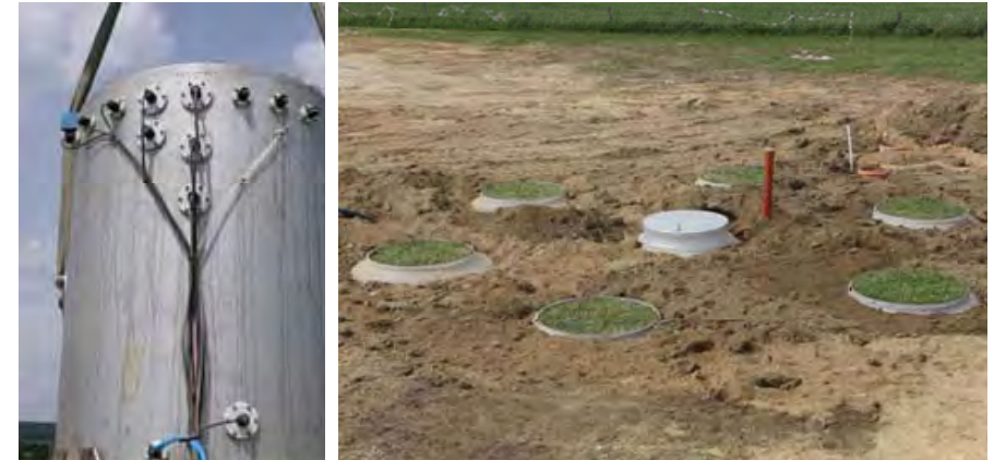
Abbildung 6: Komplet instrumentiertes Lysimeter (links), Lysimeteranlage in Rollesbroich (Observatorium Eifel/Niederrheinische Bucht) kurz vor der Fertigstellung (rechts).
