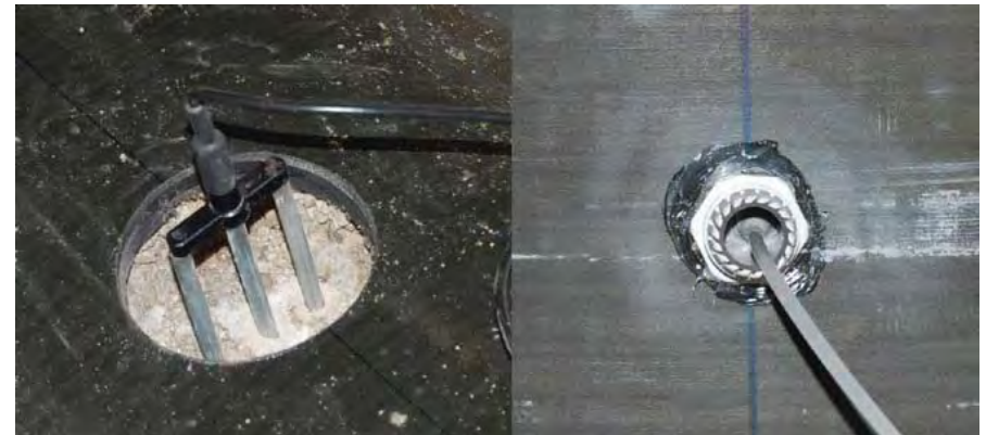
Abbildung 4: Einbau der TDR-Sonden und Tensiometer
