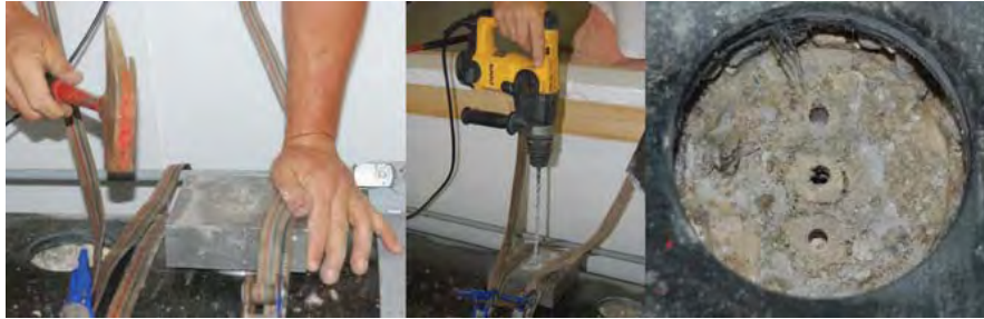
Abbildung 3: Herstellung der Bohrungen in den Schotter
