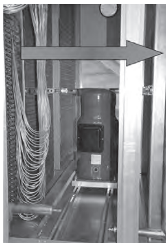
Abbildung 8: Luftführung durch den Wärmepumpen-Wärmetauscher (Entfeuchter)
