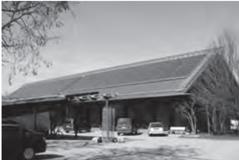
Abbildung 2: Luftkollektoren auf der Trocknungshalle der LfL
