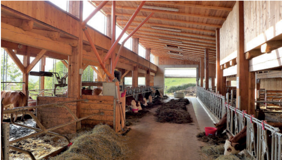
Abbildung 2: Eine umfangreiche Planungsphase und der Erfahrungsaustausch mit BerufskollegInnen bilden die Grundlage für die Umsetzung einer individuellen Baulösung (Foto am EIP-Bergmilchvieh-Projektbetrieb Feiner).
