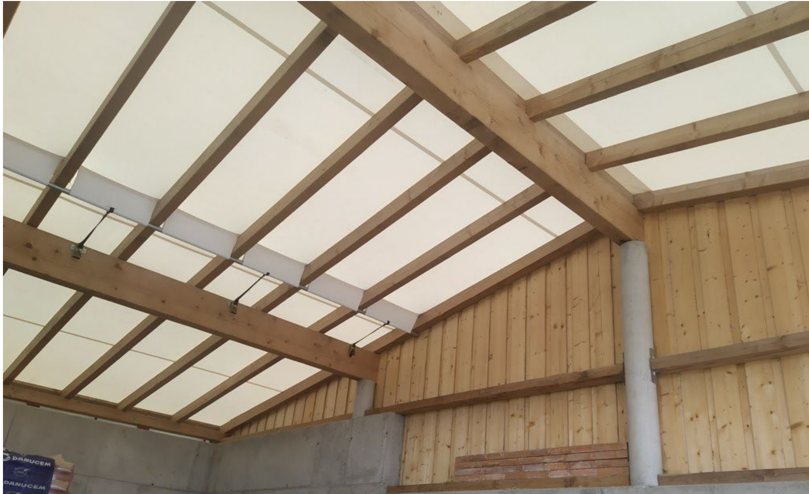
Überdachung eines Abstellplatzes
