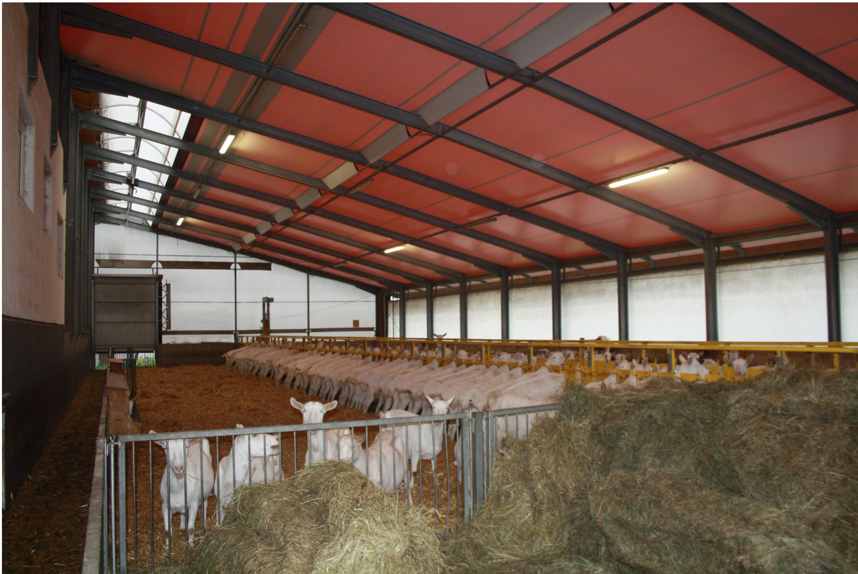
Innenansicht: frei gespannte Konstruktion, giebelseitig Netzbespannung, ausreichend Entlüftungs- und Belichtungsmöglichkeit zum Altbestand hin
