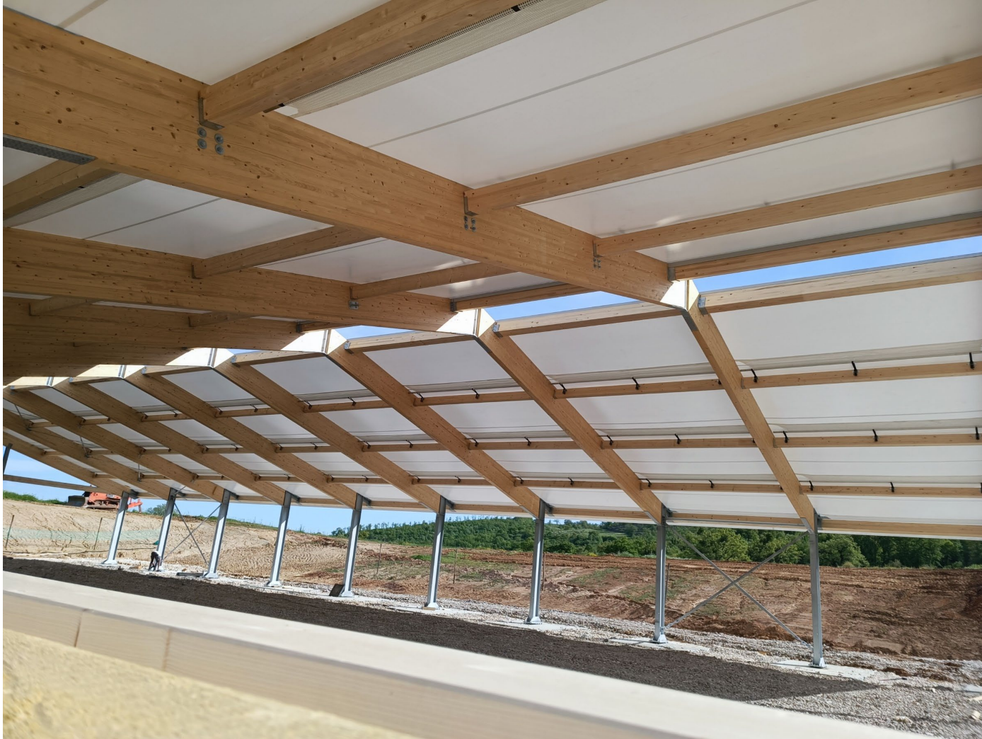
Aufnahmen einer Baustelle in der Toscana
