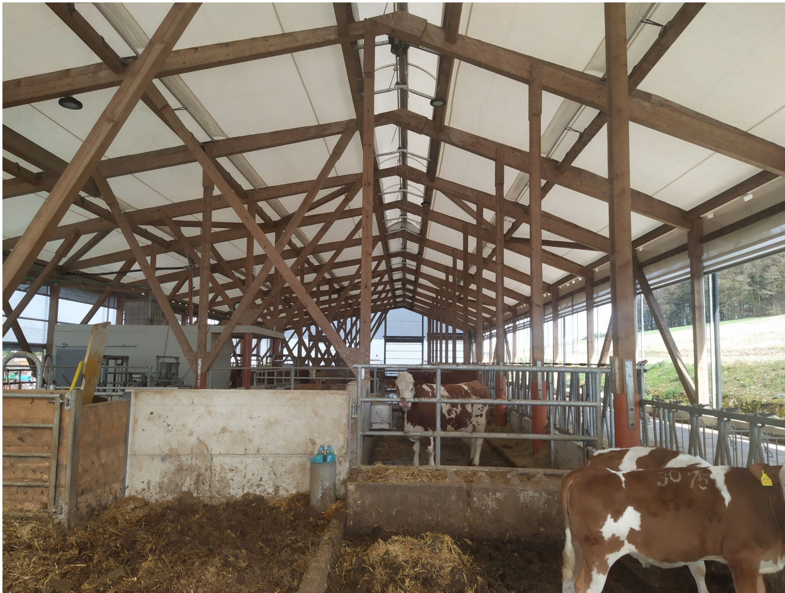
Holzkonstruktion mit Membraneindeckung und großzügigem Lichtfirst
