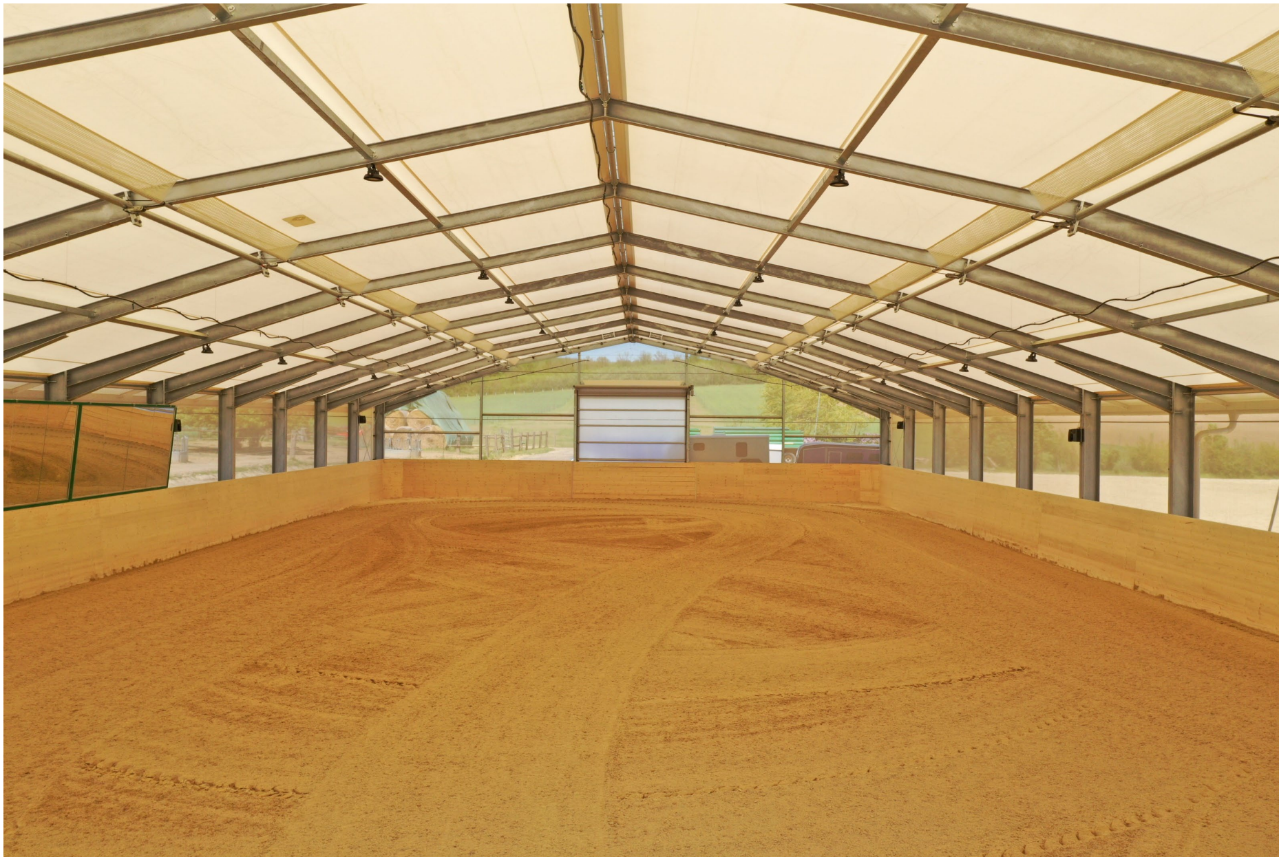
Reithalle, Profilträgerkonstruktion in Verbindung mit Windschutznetzen und Rolltor
