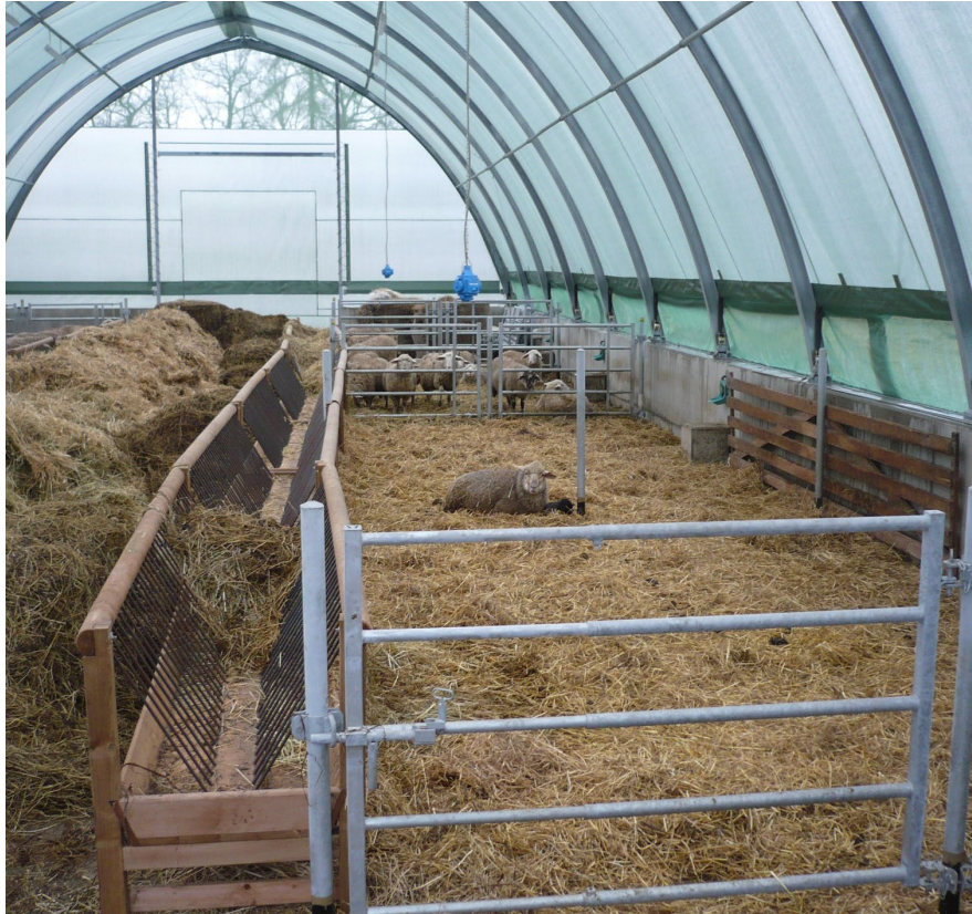
Profilträgerbogenhalle auf Betonmauer aufgesetzt, im oberen Giebelbereich beidseitig Netzbespannung
