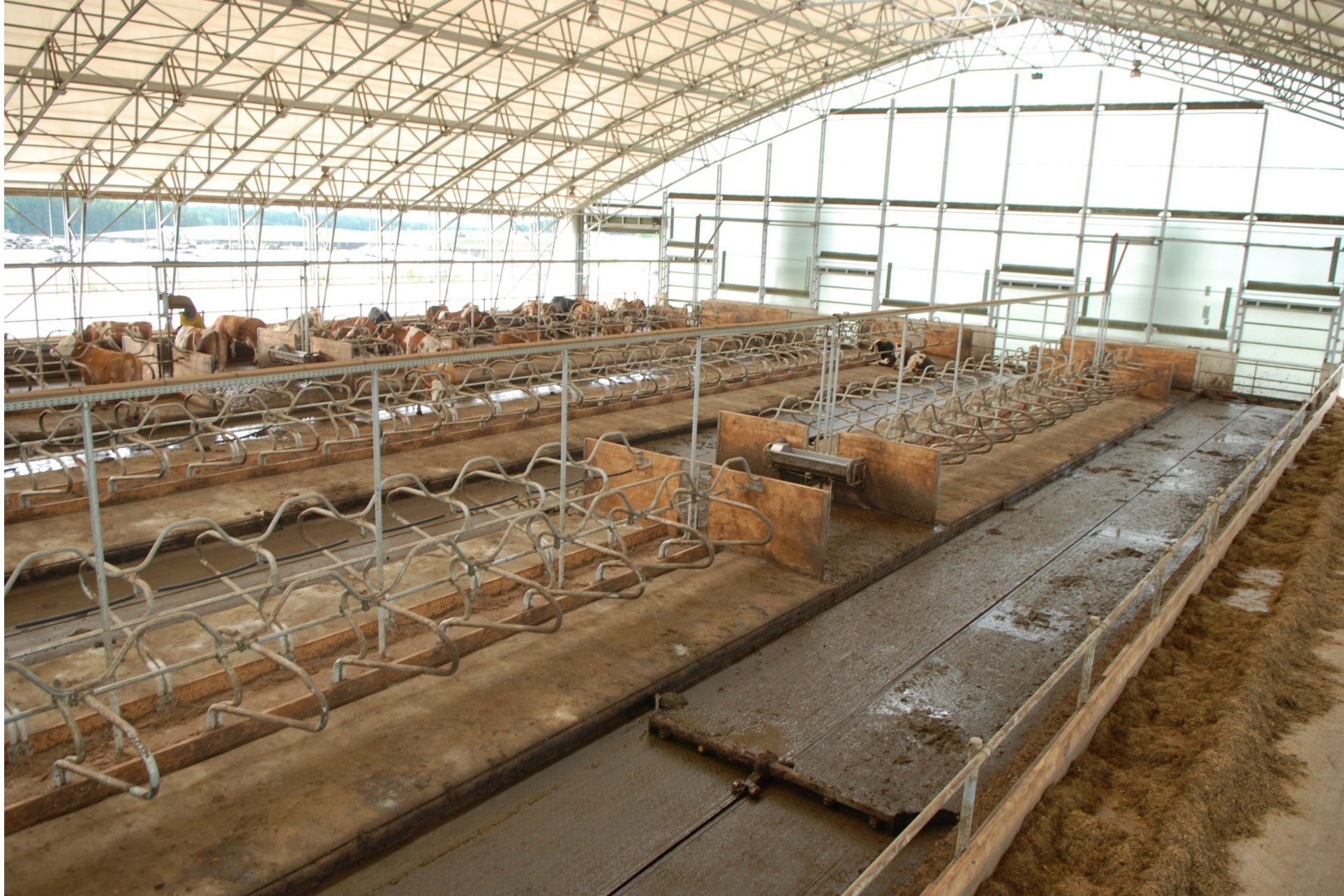
Stützenlose Gitterrahmenkonstruktion, Bedürfnisse der Rinder stehen im Vordergrund
