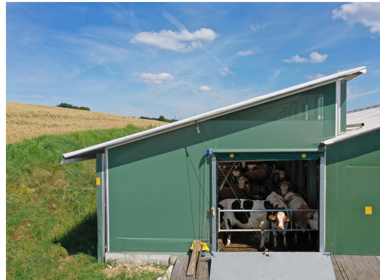
Erweiterung eines Rinderstalles
