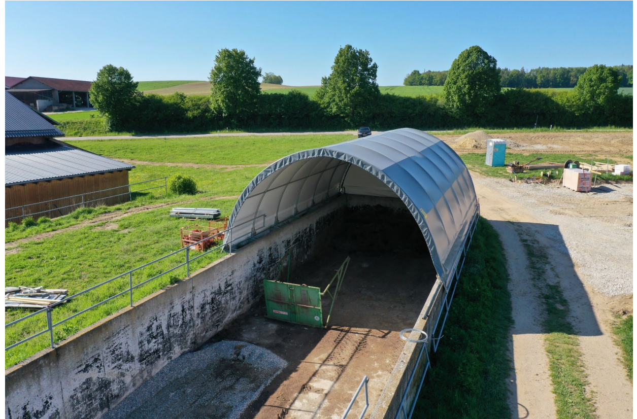
Nutzung bestehender Aufmauerungen (Fahrsilo, Festmistlager) als überdachte Lagerfläche für Maschinen/Geräte, Bergeraum oder Hackschnitzellager
