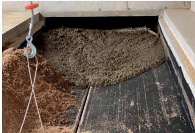
Abbildung 4: Schieberentmistungstechnik im Auslaufbereich (Quelle: HBLFA Raumberg-Gumpenstein)
