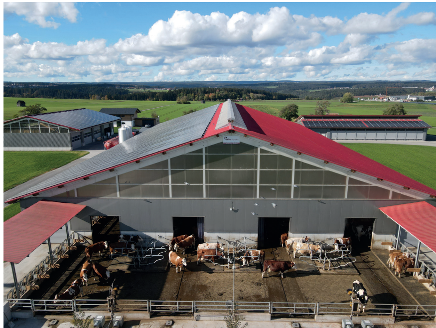
Abbildung 2: Strukturierter Laufhof mit nicht überdachten Hochboxen und zusätzliche Fressplätze, Tränkebecken und Kuhbürsten
