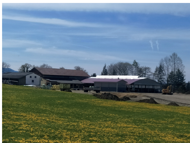
Der Großteil der Pläne wurde entsprechend dem Bestand in „ziegelrot“ ausgeführt. Foto: Huber
