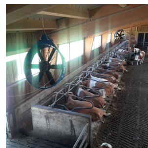
Abbildung 4: Kühlung einer Liegeboxenreihe mittels Ventilatoren
