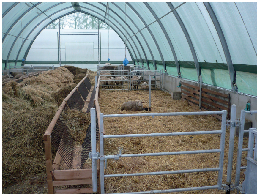
Schafstall mit seitlicher Aufmauerung und aufgesetzter und verankerter Bogenhalle
