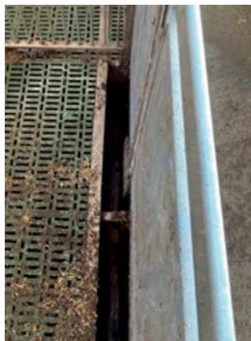
Abbildung 3: Kotschlitz am Ende des Ausscheidungsbereichs
