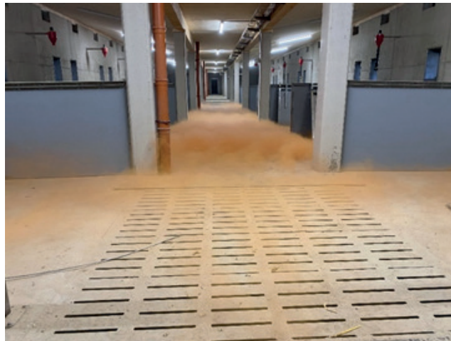
Abbildung 2: Stallinnenraum mit zuluftführendem Kontrollgang, Liegebereich links und rechts mit verschiebbaren Buchtenrückwänden (Quelle: HBLFA Raumberg-Gumpenstein)
