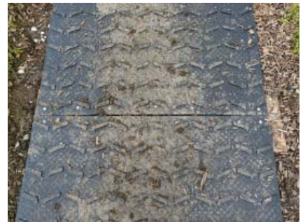
Foto 5: Kunststofflochmatten für Steigungen
