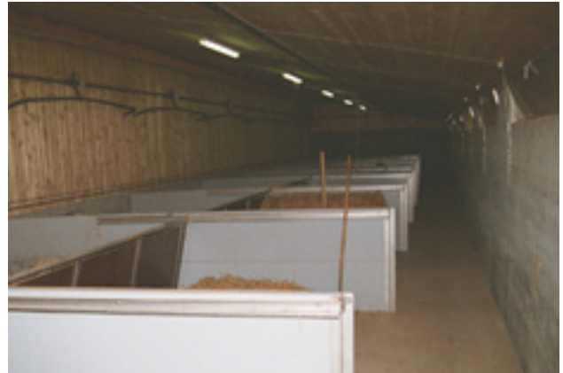
Abbildung 5: Stallinnenraum mit Kontrollgang, Liegebereich und verschiebbaren Buchtenrückwänden (Quelle: Schauer Agrotronic GmbH)
