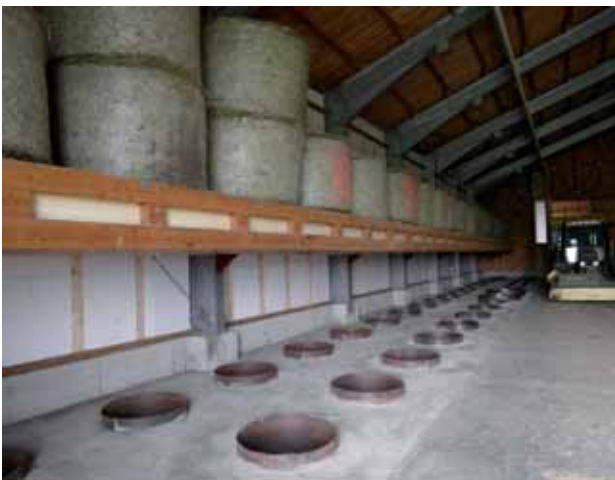
Bild 3: Modellbetrieb mit zweireihigem Betonkanal und darüberliegendem wärmeisoliertem Blechkanal sowie gedämmter Wandseite.
