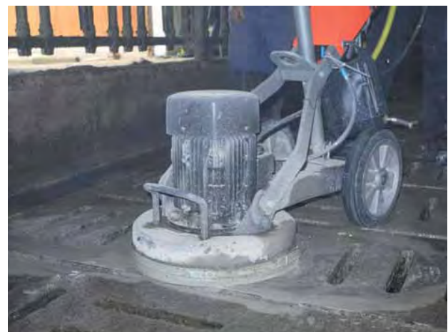
Bild1: Das Kugelgranulat Scheuern mit der Schleifeinheit zum Sanieren von planen Oberflächen
