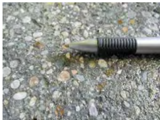
Bild 2: Oberflächenstruktur unmittelbar nach dem „Kugelgranulat Scheuern“
