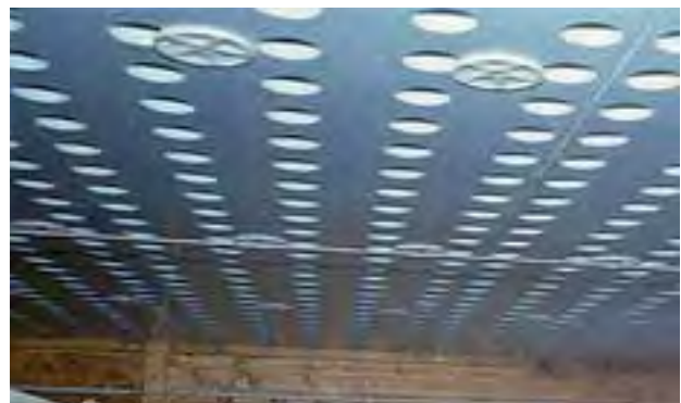
Abbildung 9: Gelochte Kunststoffplatten als Zuluftelement
