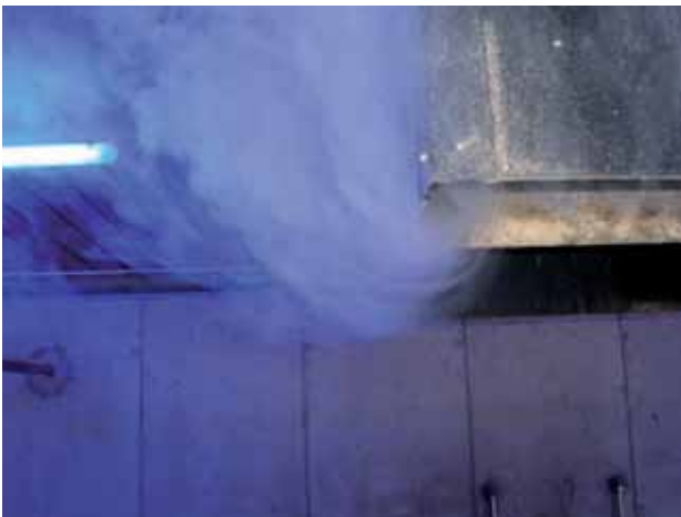
Abbildung 23 und 24: Frischluft wird unmittelbar wieder abgesaugt. Die Wärmebildaufnahme verdeutlicht diesen Mangel.
