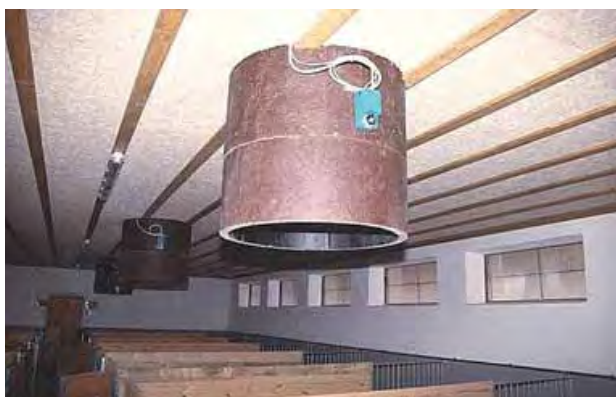
Abbildung 16: Klassische Porendecke mit Heraklith - Holzwolleplatte
