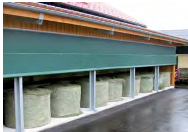
Bild 2: Ballentrocknung mit Untenbelüftung und Rollplane
