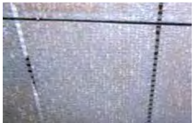
Abbildung 7: Textil- oder Kunststoffgeflecht (ACC) als Zuluftelement
