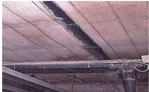
Abbildung 8: Textilgeflechte haben keine lange Lebensdauer
