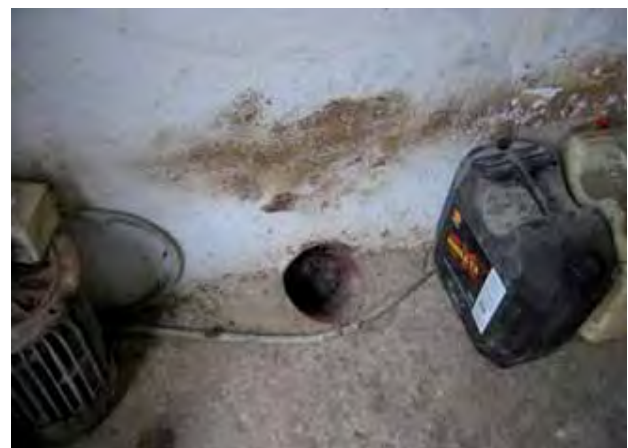
Abbildung 19: Direkter Falschlufteintrag in das Abteil
