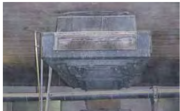
Abbildung 4: Rechteckige Strahl Lüftungseinheit mit Öffnungen in 4 Richtungen
