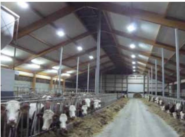
Abbildung 1: Blick in einen Milchviehstall mit eingeschalteten LED-Strahlern und Leuchtstoffröhren; rechts ist ein LED Strahler mit 1200 Einzel-LED's zu sehen
