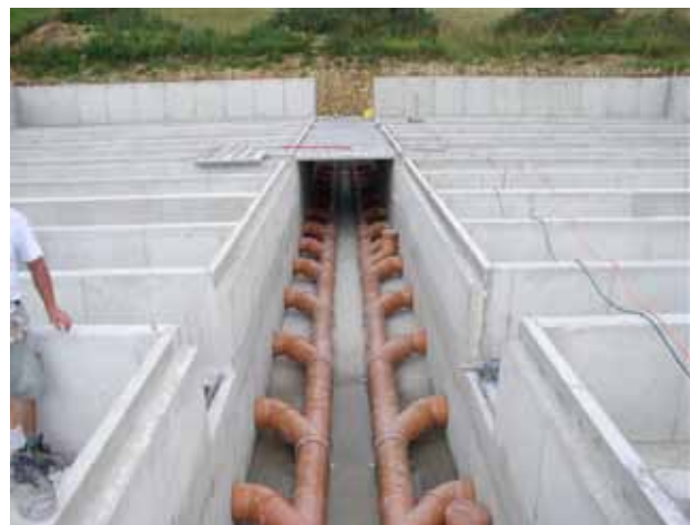
Abbildung 3: Erdwärmetauscher – Unterflurzuluftkanal (Quelle: Geißler, LSZ Boxberg)
